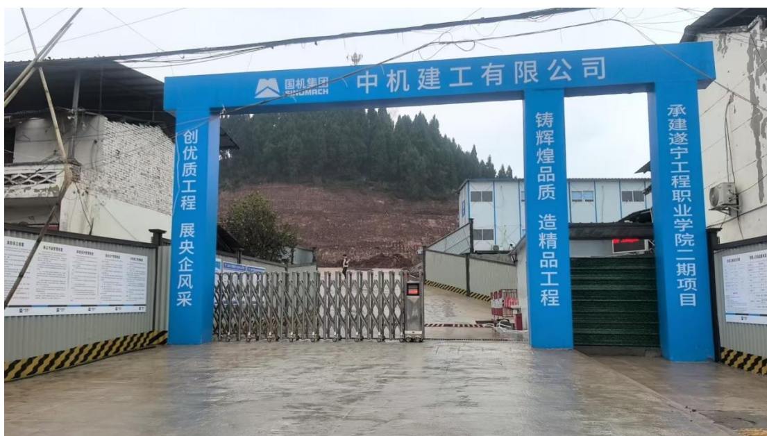
图 2-10 学校二期建设施工现场
